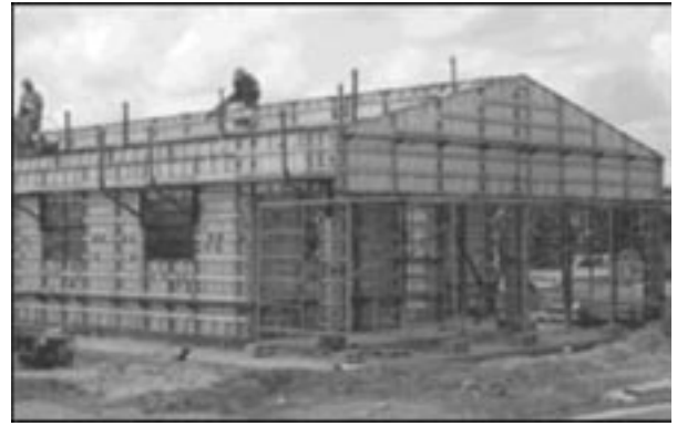
Figura 1a. Sistema de encofrado de aluminio FORSA.
